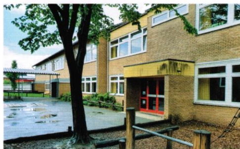
Grundschule Gildehaus: Dringender Handlungsbedarf
