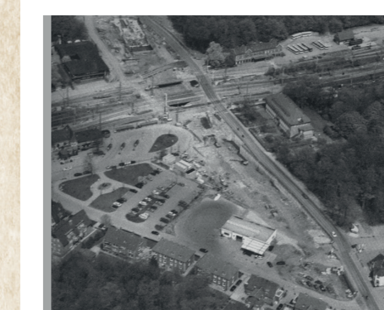
Baustelle der Unterführung von oben (Luftaufnahme, vermutlich aus den Grafshafter Nachrichten)
