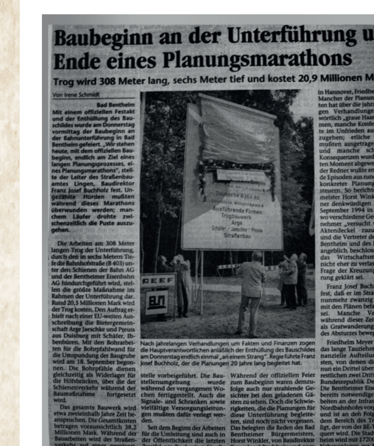
Die langen Wartezeiten vor dem Bahnübergang sollen ein Ende haben, Beginn des Baues der Unterführung (Artikel Grafshafter Nachrichten vom 08.09.1995)
