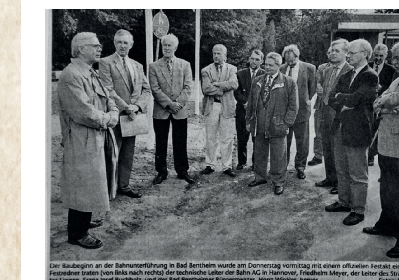
Erster Spatenstich zum Bau der Unterführung (Artikel Grafshafter Nachrichten vom 08.09.1995)
